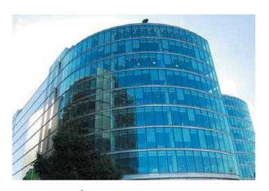
стеклопакета в фасаде осуществляется за счет вклеивания в стеклопакет специального крепежного профиля. Стыки межу стеклопакетов герметизируются либо герметиками, либо специальными герметизирующими профилями из резины.
